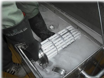
干式泵冷却器洗净现场
