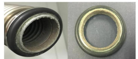
洗涤器内部的 腐蚀状况
